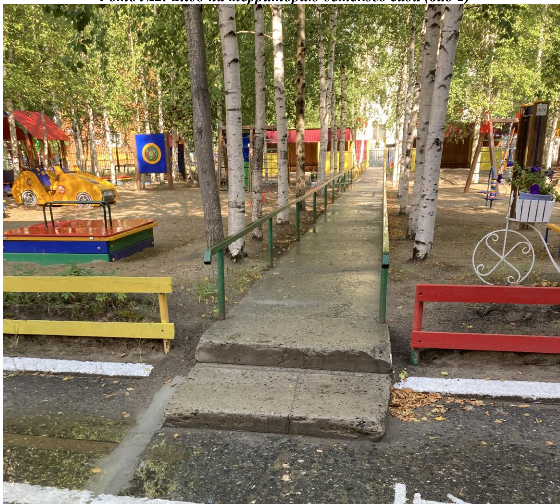
Фото №2. Вход на территорию детского сада (вид 2)
